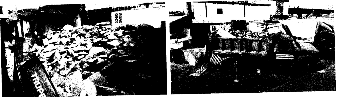
Fotografía 7.- Eliminación de material demolido o excedente.
